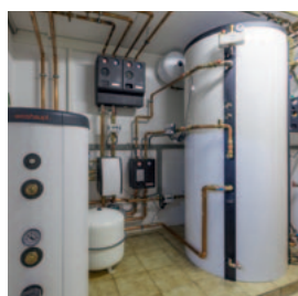
Il nuovo sistema a pompa di calore con accumulatore di energia e serbatoio polmone.
