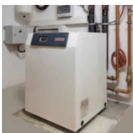
Il nuovo sistema a pompa di calore con accumulatore di energia e serbatoio polmone.
